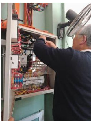
制御盤への設置
